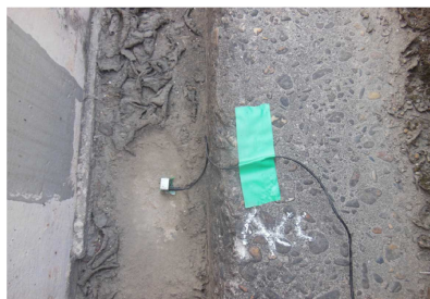
(가속도계 설치 현황)
