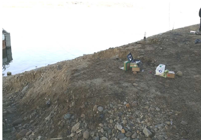
(처짐계 설치 전경)
